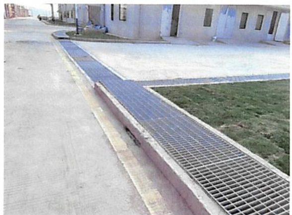
砖砌雨水沟现状
