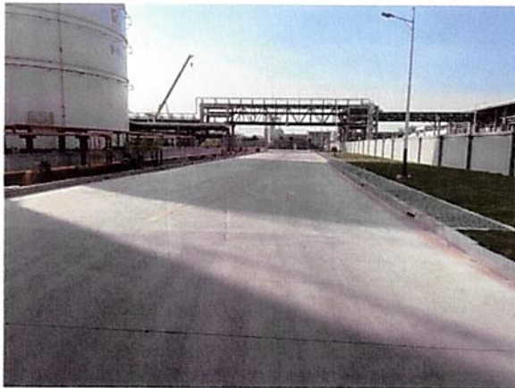
生产区道路现状
